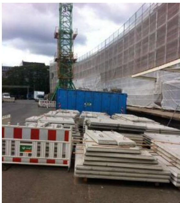
Noch wird hier fleißig gebaut, doch im September 2014 soll die Rindermarkthalle eröffnet werden.
