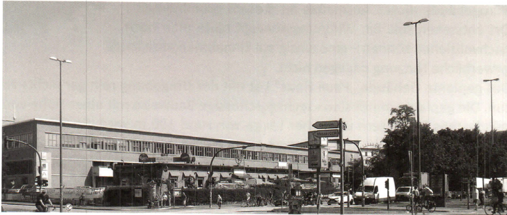
Freier Blick auf das historische Ensemble
