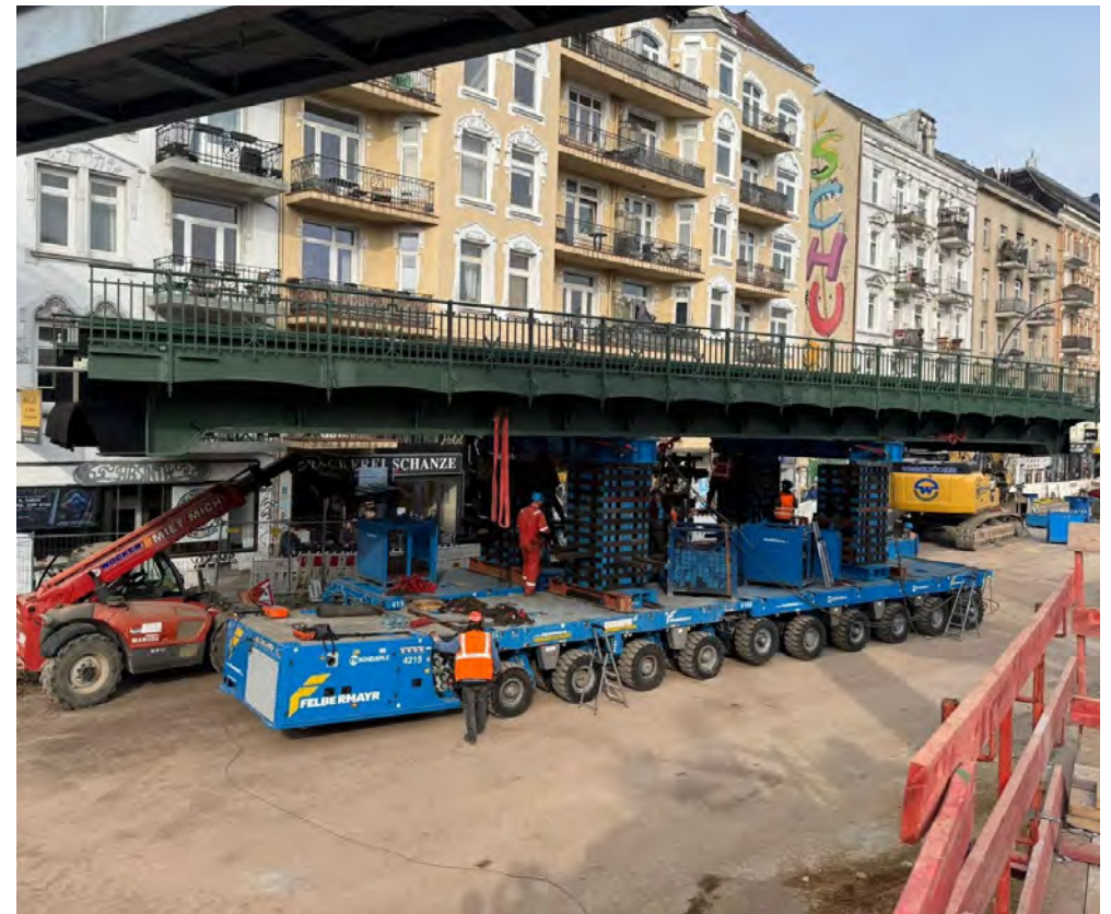
Einsatz eines Modulfahrzeugs (Self-Propelled Modular Transporter, SPMT) im Projekt EÜ Schanzenstraße, 13.03.2026
